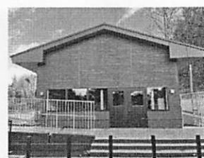
3号発電機のある建屋
