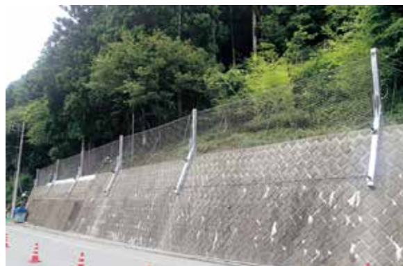
TFバリア設置完了
