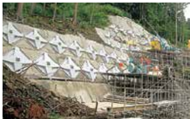
グラウンドアンカーによる地すべり対策工事
