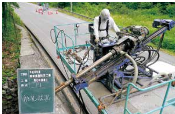
高所作業車を利用した削孔状況
