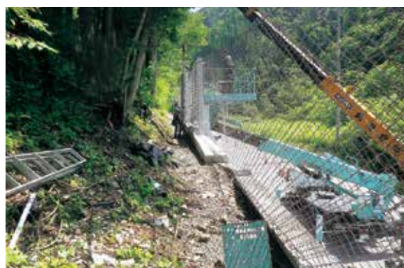
小型クレーン及び高所作業車によるネット設置
