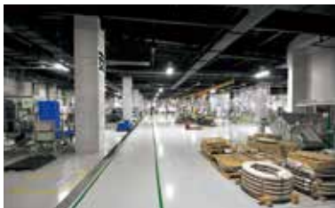
テクノロジーセンター輝の地下工場
