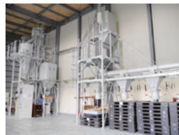
自家精米設備
