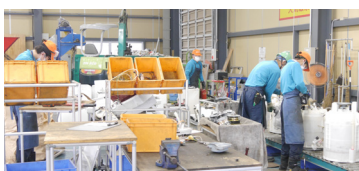
障がい者、高齢者などが手作業で解体
