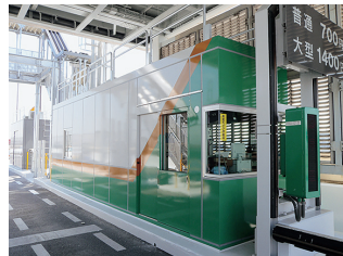
高速道路料金所ブース
