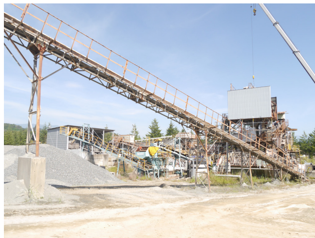
砂利製造プラント
