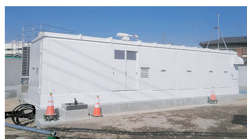
建設中の水素ステーション（長野市北長池）
