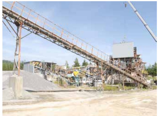
砂利製造プラント
