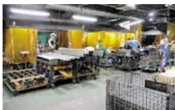
溶接ロボット並ぶ溶接工程
