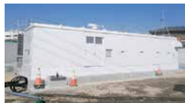
建設中の水素ステーション（長野市北長池）
