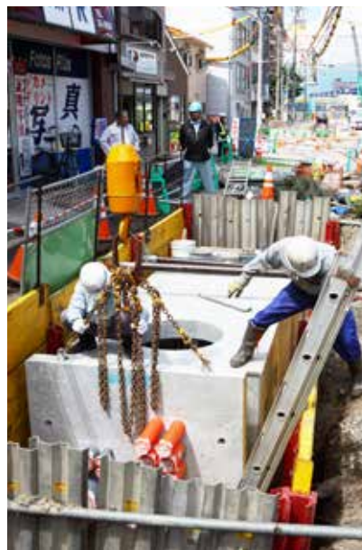
施工事例 電線共同溝
