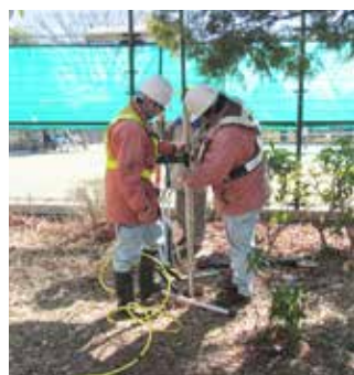
地下空洞計測
