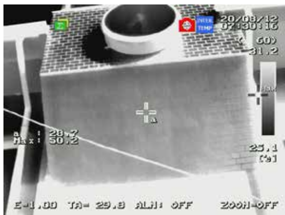
外壁タイルの浮きや剥離の調査事例(サーモグラフィ画像)
