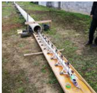
地下埋設管配管位置計測システム
