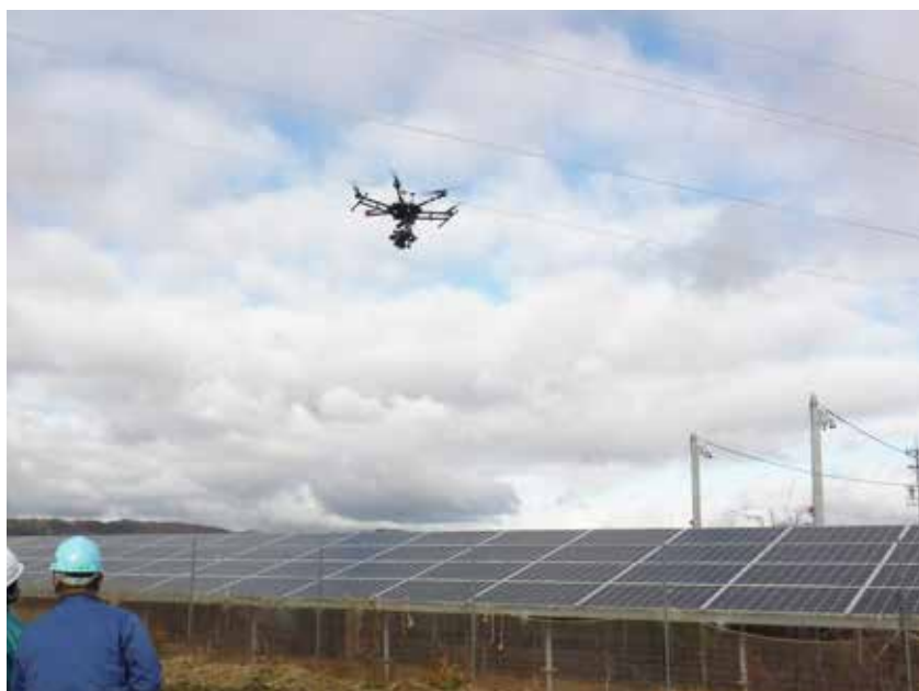
ドローンによる太陽光パネル調査
