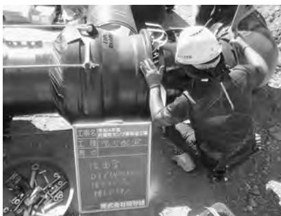
ポンプ場内配管工事
