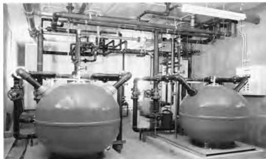
温泉ろ過機廻り工事
