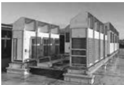
建築機械設備工事(飯田市役所)
