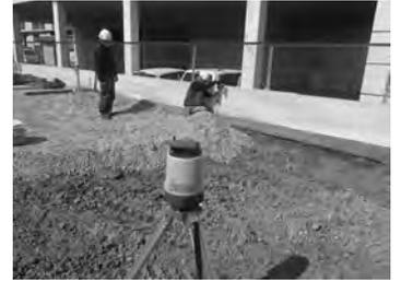
測量誘導システム（杭ナビ）による作業
