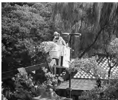
電気設備の点検
