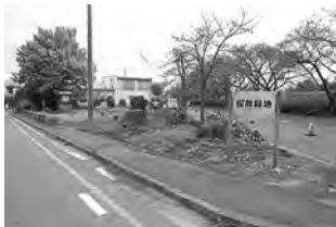
桜舞緑地公園整備工事
