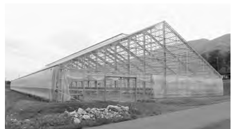
鉄骨造りの大型いちご栽培ハウス
