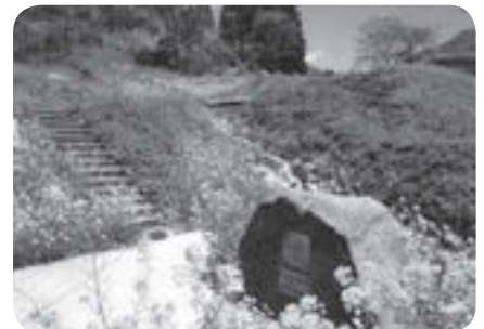
薬師沢石張水路工
