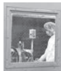
クリーンルームの塗装作業
