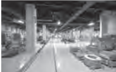
テクノロジーセンター輝の地下工場
