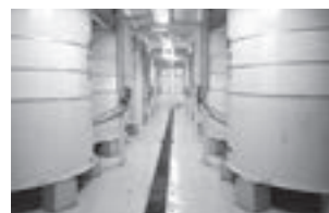
富士見蔵の貯蔵タンク
