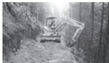
作業路網整備。作業路の開設で生産性の高い山づくりを支援
