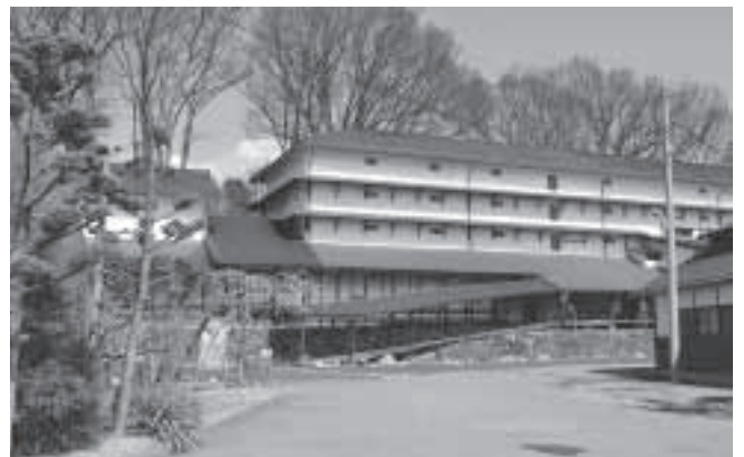
木造5階建繭倉庫
