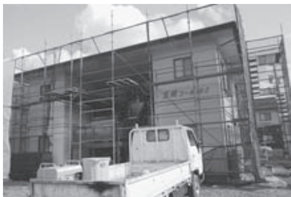
アパート外壁塗装のクリーニング工事
