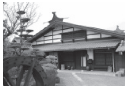
築270年の本棟造りの「館そば」外観
